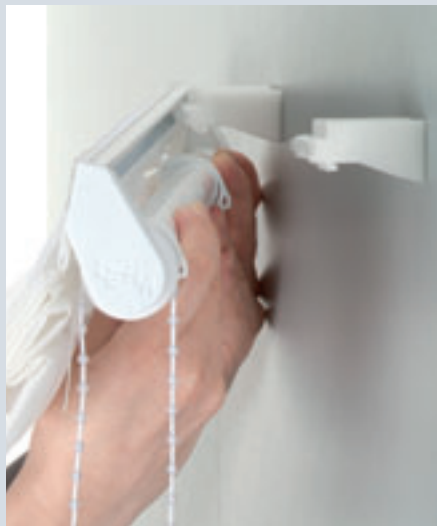
Einclippen des Profils, zuerst an Profiloberkante einhängen, dann nach unten drücken, bis zum hörbaren Klicken.
